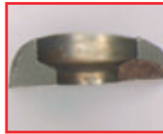
Brekkasje i "countersunk" skruehode
